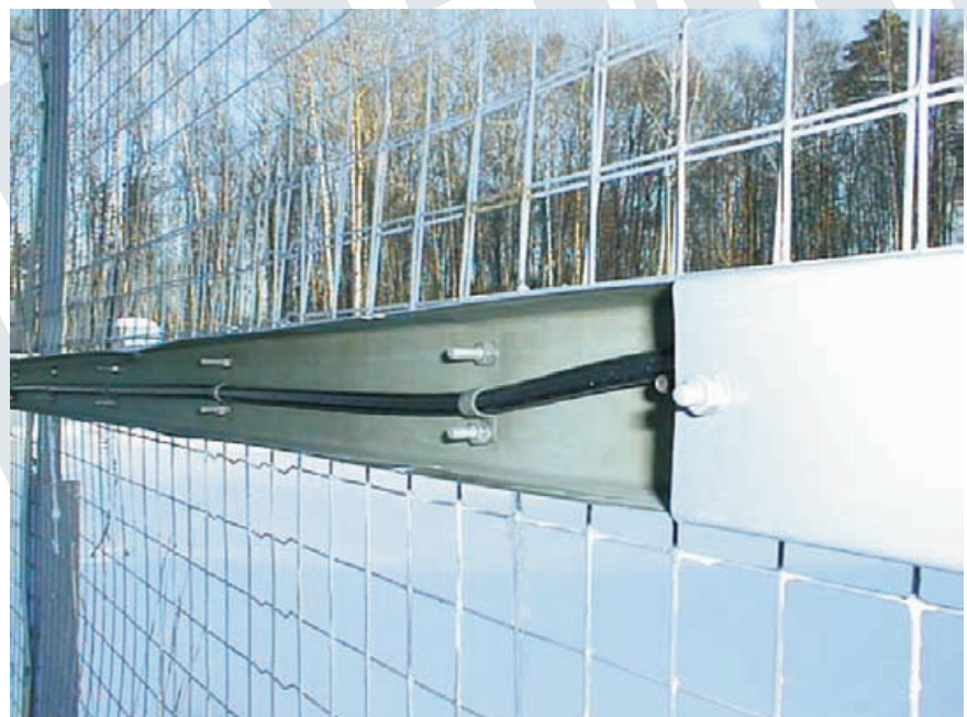
Крепление кронштейна короба к сетчатому заграждению
