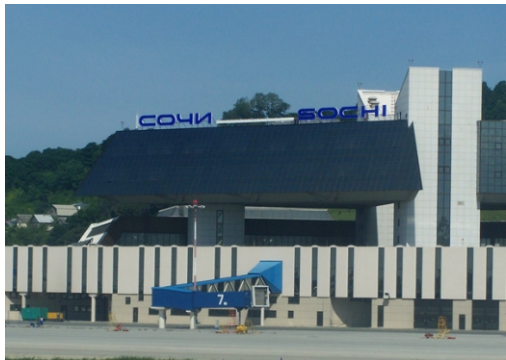
Объект: Терминалы аэропорта Сочи. Город: Сочи. Вид работ: Пуско - наладка автоматического модуля насосной станции для систем пожаротушения АМНС.
