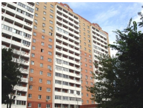
Объект: 17-этажный дом. Город: Москва. Вид работ: Проектирование и монтаж системы водяного пожаротушения водой для мусоропроводов (на базе оборудования ЗАО "ПО "Спецавтоматика" г. Бийск), системы пожарной сигнализации и системы оповещения и управления эвакуацией людей при пожаре.
