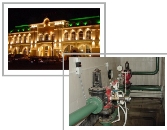
Объект: Железнодорожный вокзал. Город: Хабаровск. Вид работ: Монтаж систем водяного пожаротушения помещений вокзала.
