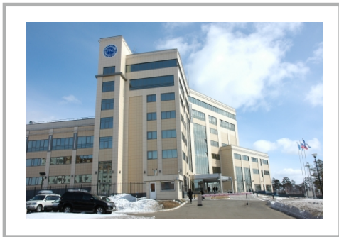
Объект: Здание ОАО "АК "Транснефть". Город: Братск. Вид работ: Монтаж систем автоматического газового пожаротушения, охранно-пожарной сигнализации.
