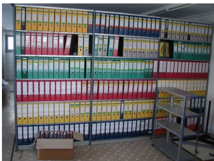
Объект: Государственный архив. Регион, город: Республика Хакассия, Абакан. Вид работ: Проектирование и монтаж системы пожаротушения тонкораспыленной воды, пожарной сигнализации, системы оповещения и управления эвакуацией людей при пожаре в помещениях архива.
