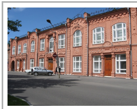
Объект: Библиотека им. В.М. Шукшина. Город: Бийск. Вид работ: Монтаж и пуско - наладка системы водяного пожаротушения на базе оборудования ЗАО "ПО "Спецавтоматика" г. Бийск (насосная станция, КПУУ "Спринт", оросители ТРВ), системы охранно-пожарной сигнализации, системы управления клапанами огнезадерживающими, монтаж системы вентиляции, монтаж системы оповещения и управления эвакуацией людей.
