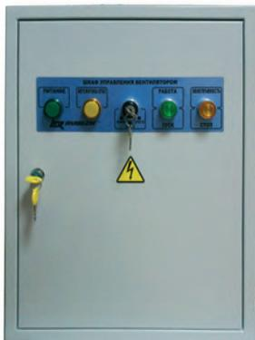
Шкаф управления вентилятором предназначен для управления электроприводом вытяжного или приточного вентилятора автоматической системы противопожарной вентиляции.
